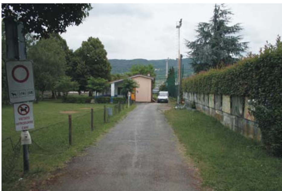
foto ingresso da Via Volta prima dell'intervento
