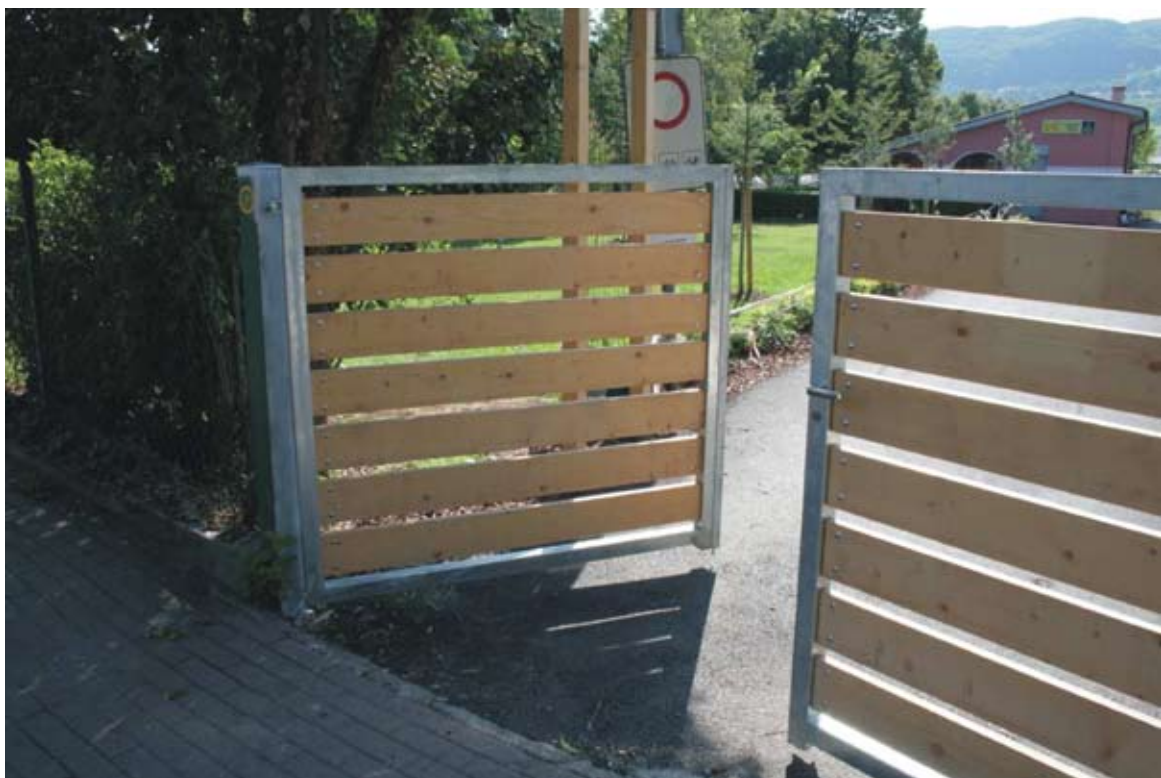
Cancello ingresso da Via Volta dopo l'intervento
