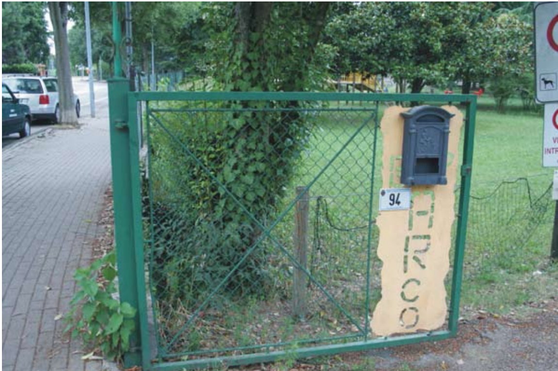
Cancello ingresso da Via Volta prima dell'intervento
